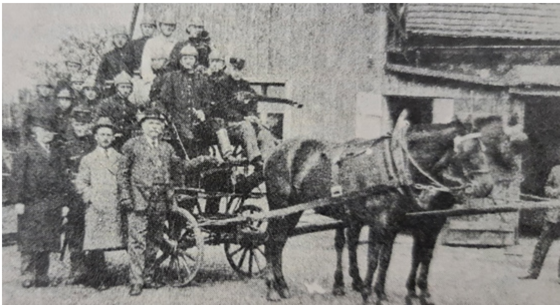
První požární stříkačka na Pražáče
